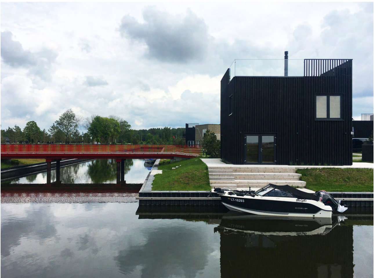
DO ARCHITECTS, Svencelės salos // Profil: Mykolas (19x92, 19x117, 26x68, 42x92, 42x140) pokryty czarną bejcą Tikukurila Wood Stain 5089, taras Mykolas (26x117) bez powłoki // Architekci: DO ARCHITECTS, Karresen Brand (plan generalny) // Zdjęcia: DO ARCHITECTS, Svencelės salos
