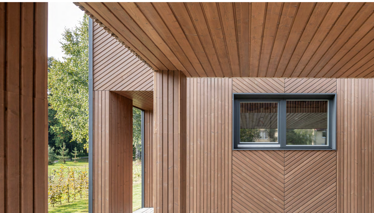
Birštonas // 2022 // Profil: Urtė (16x142) // Powłoka: Tikkurila 5071 // Architekci: „Kubinis metras” // Zdjęcia: A. Garbačiauskas // Dewetloper: „Sluoksniš”
