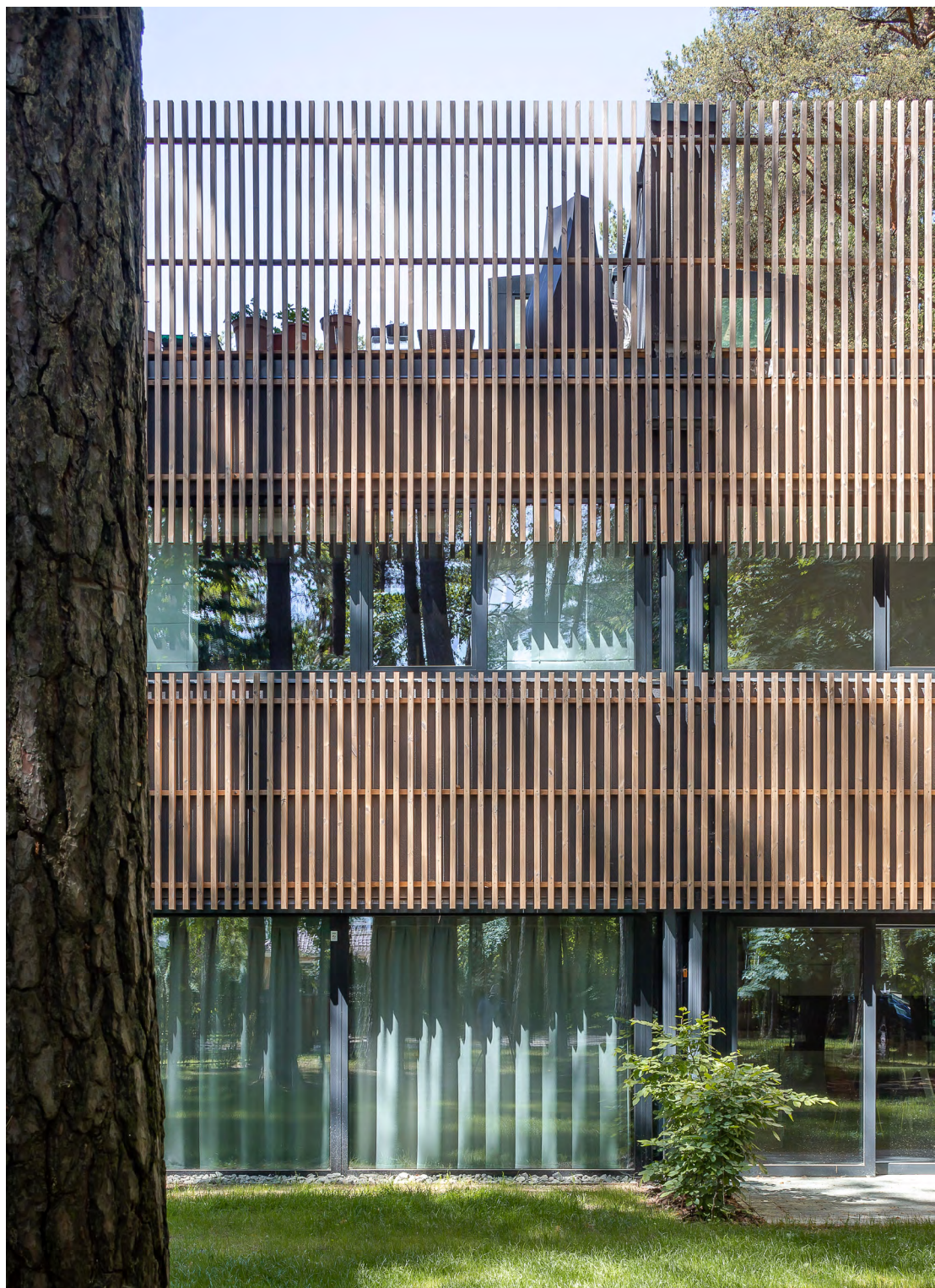
Budynki mieszkalne „Pasakų parkas” // Wilno, 2018 // Profil: listwa 42x68 // Powłoka: bezbarwny WoodCream // Architekci: Paleko architektų studija i KAParchitects // Zdjęcie: Norbert Tukaj
