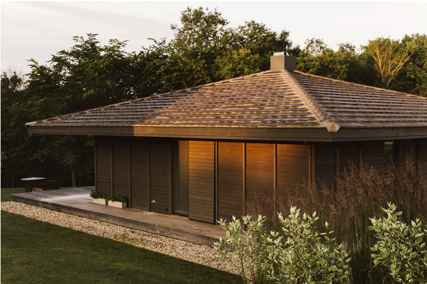
Projektas "Gervė" // Architektai: Šilta šiaurė // Tašas 42x42, Tikkurila Wood Stain 5083 // RŪTA 19x117 Tikkurila Wood Stain 5083 // Nuotraukų autorius: Algirdas Bakas
