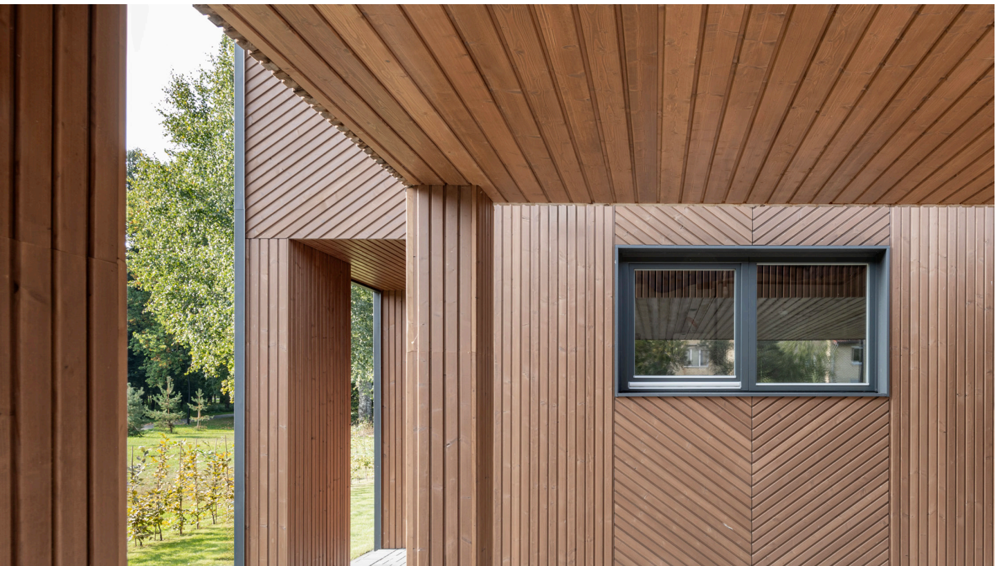
Birštonas // 2022 m. // Profilis: Urtė 26x142 // Padengimas: Tikkurila 5071 // Architektai: „Kubinis metras“ // Nuotraukų autorius: A.Garbačiauskas // Vystytojas: „Sluoksnis“
