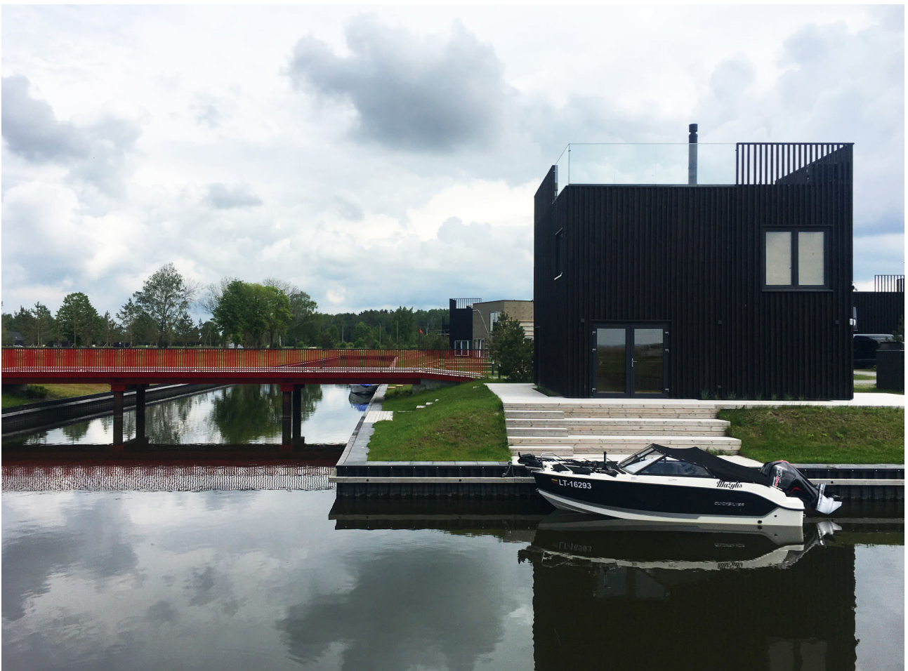
DO ARCHITECTS, Svencelės salos // Mykolas 19x92, 19x117, 26x68, 42x92, 42x140 dengti juodai Tikkurila Wood Stain 5089, terasa SHP 26x117 nedengta // Architektai: DO ARCHITECTS, Karres en Brands (master plan) // Nuotraukų autorius: Do Architects, Svencelės salos
