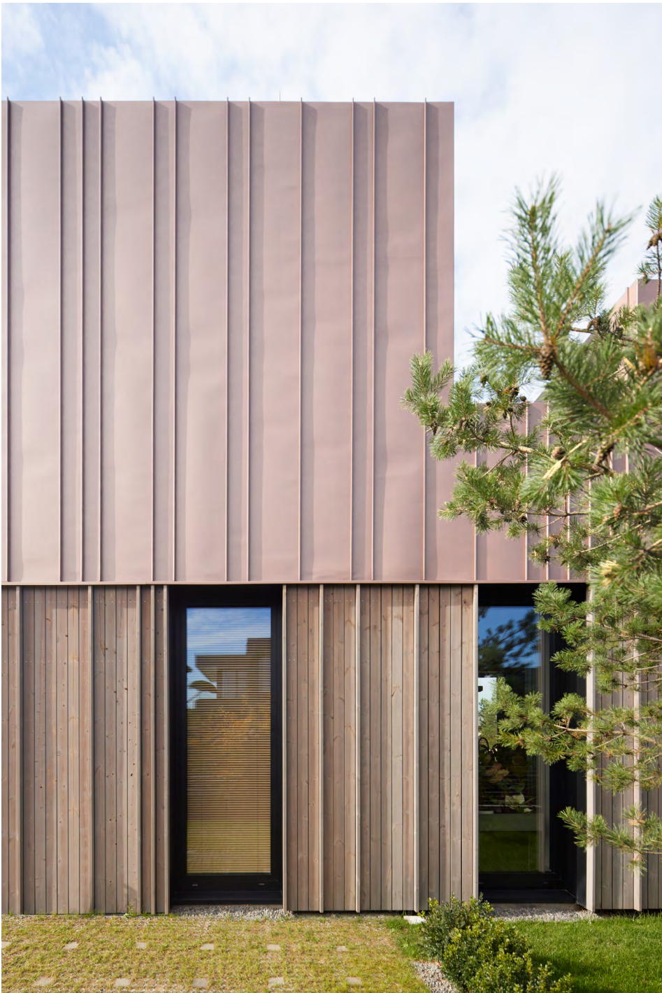
Budynek mieszkalny w Gulbinai // Wilno, 2020 // Profil: Rombas (20x92), Mykolas (26x68) // Powłoka: Teknos 1707 // Architekci: 2XJ // Zdjęcia: Norbert Tukaj
