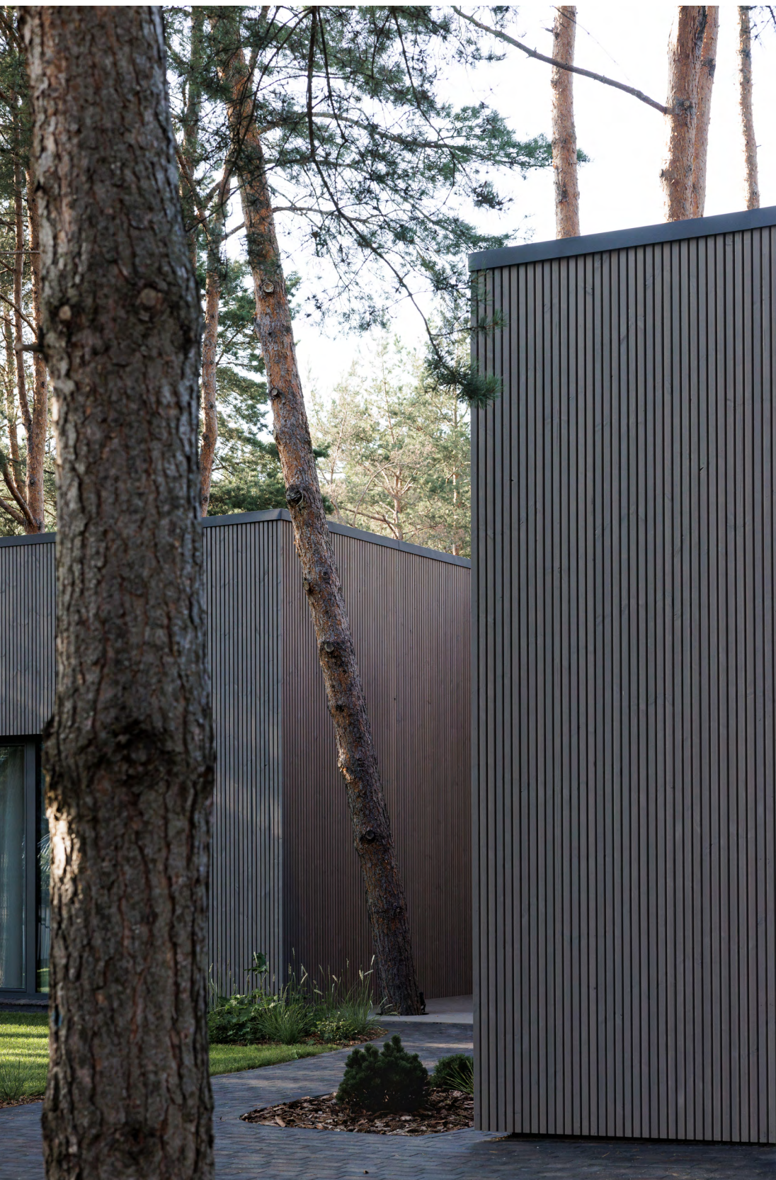
Prywatny budynek mieszkalny // Kowno, 2023 // Profile: Mykolas 26x117 i Grète 32x142 // Powłoka: TK WS 5147, bez tekstury // Architekci: Nebrau Architecture // Zdjęcie: Norbert Tukaj
